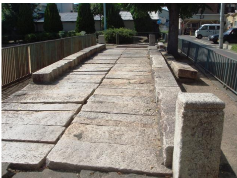
明治9年に架けられた福栄橋(八尾山本第2公園にて保存)
